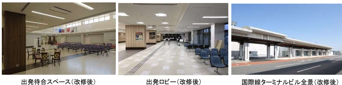
図 5 国際線ターミナルビルの増改築
